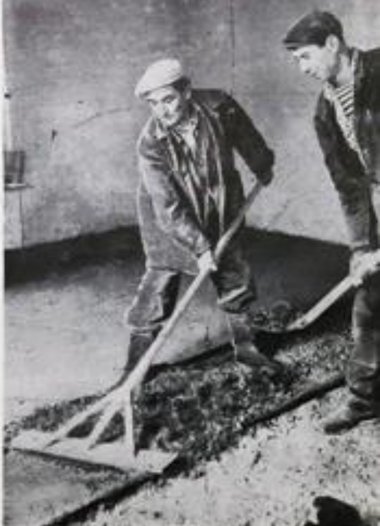
Работник 4 разряда В. А. Хасанов и Х. Х. Хасанов готовят укреплённый цементный раствор под кладку.
