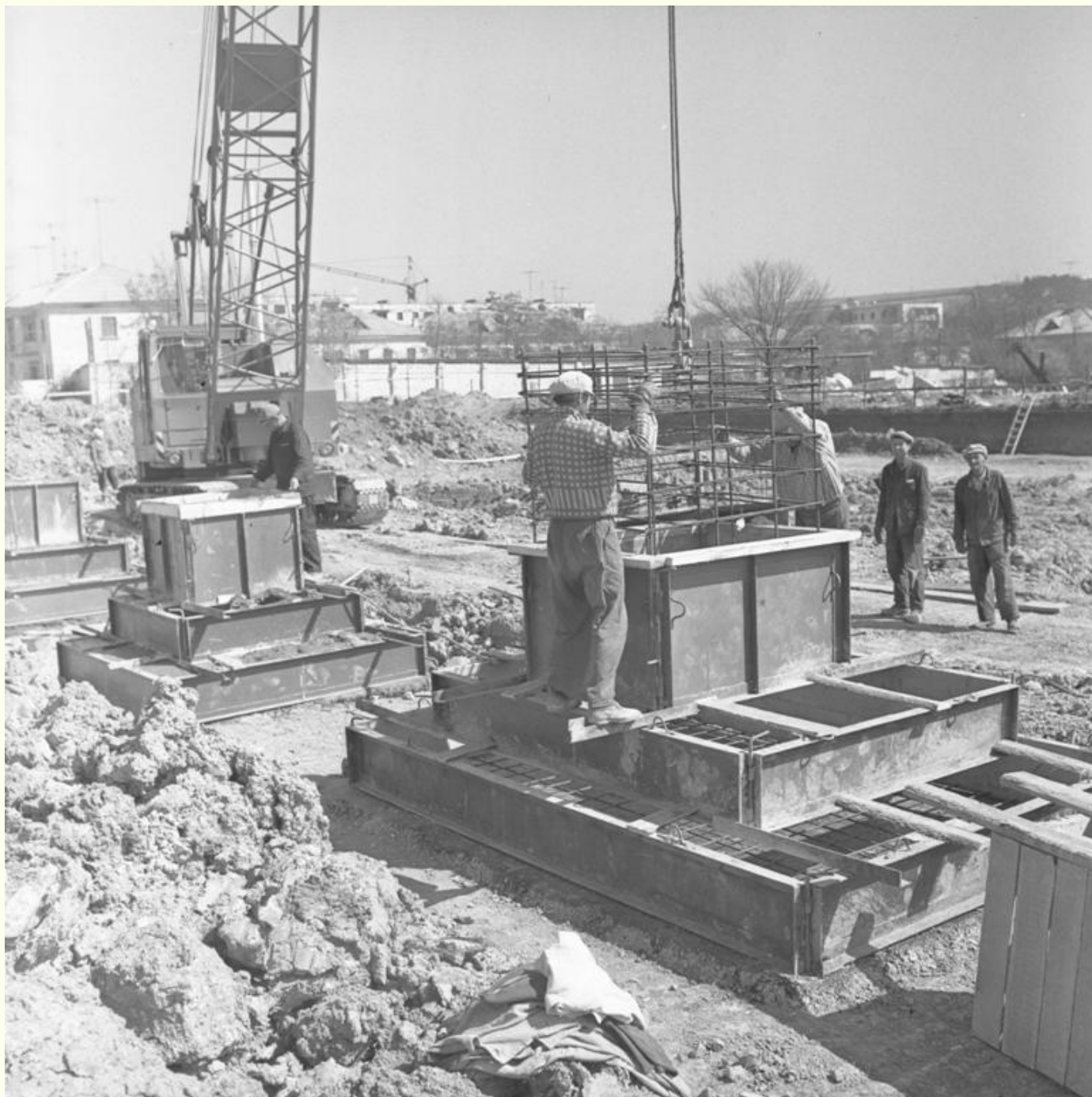
Комплексная бригада СУ-42 треста «Севастопольстрой» (бригадир Герой Социалистического Труда Е.А. Ребров) на строительстве производственного корпуса завода «Парус» 1971 г. Фото А. Баженова
